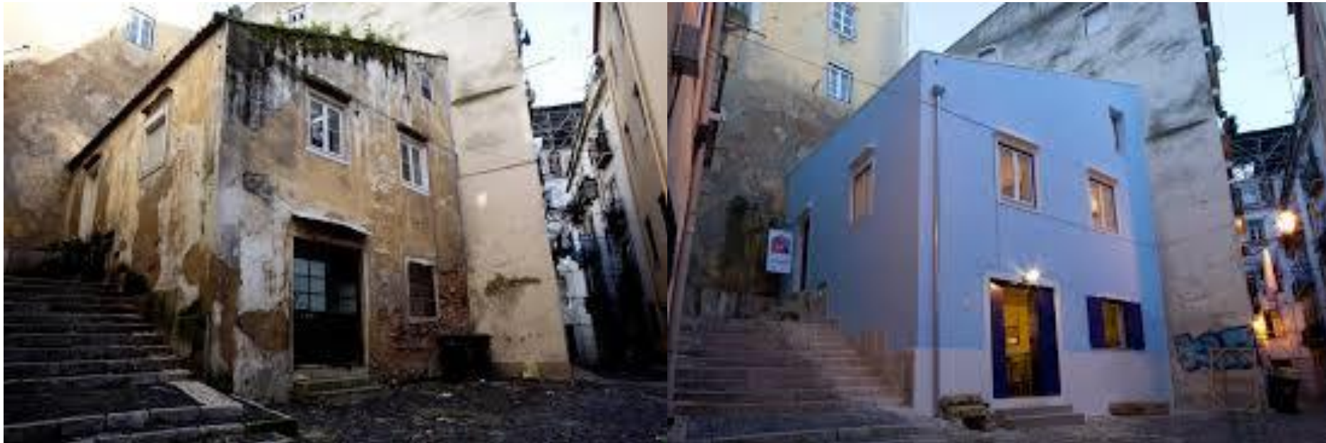
Edifício Manifesto, intervenção do atelier Arteria, Mouraria, Lisboa, 2012. Fonte: http://www.arteria.pt/portfolio/edificiomanifesto_7.html
